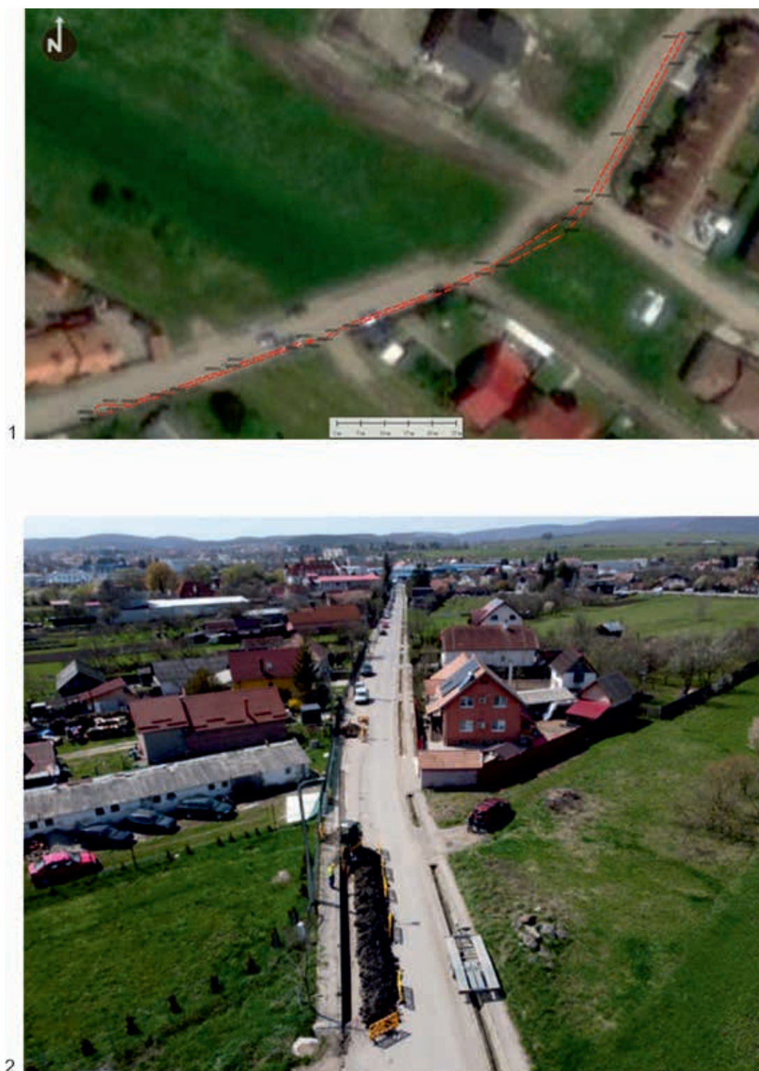
Fig. 10. Planul topografic (1) și vedere de ansamblu (2) al săpăturilor de pe strada Izvorului (conducta de gaz).
